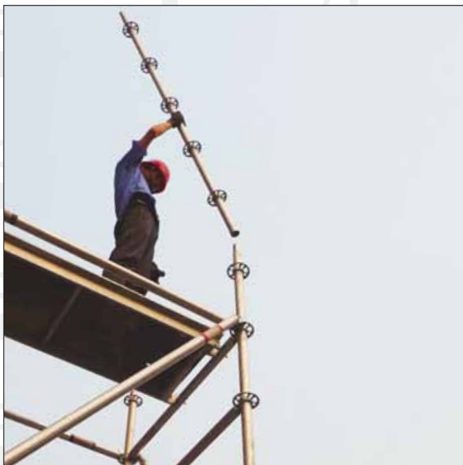
▲ 轻质铝合金零部件有助于脚手架的快速搭建，节省劳动力。
