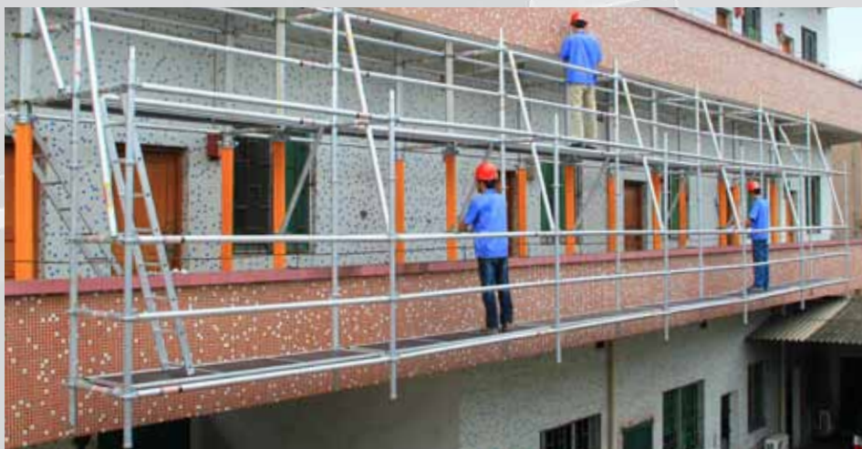
支柱配备外墙脚手架
